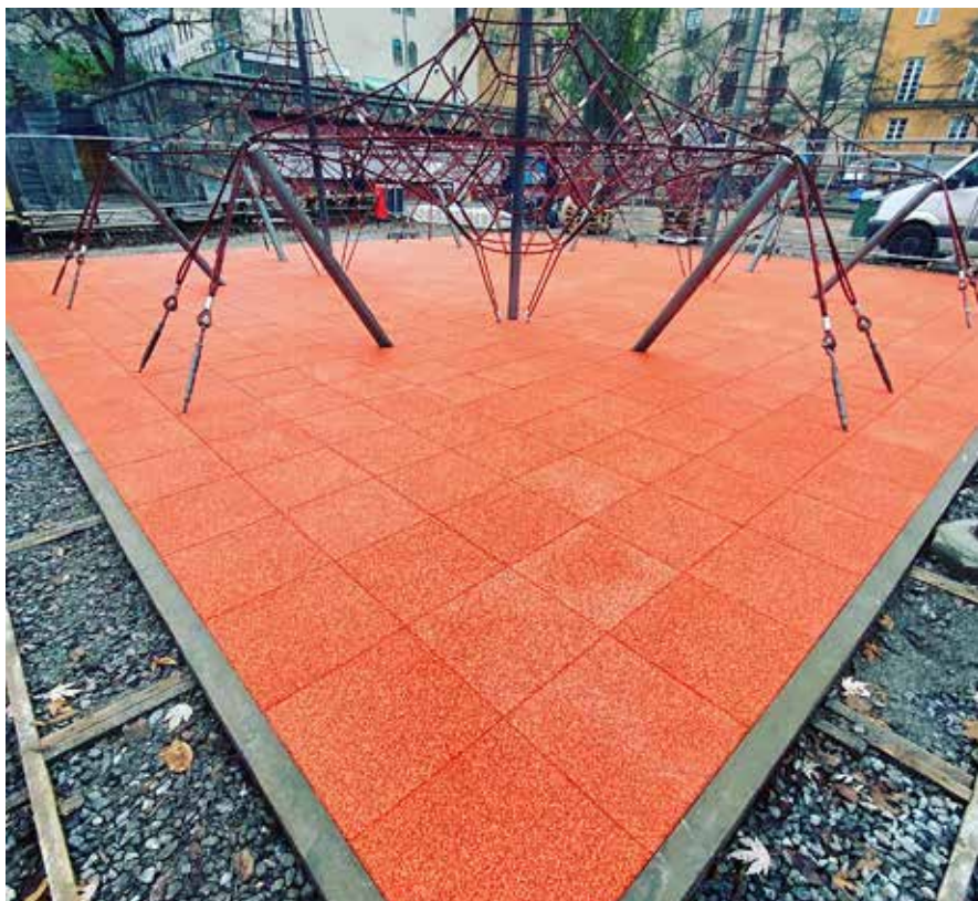
Klätterställningen i Björns trädgård har ett nytt fallskydd. Runt om har det sedan lagts nytt stenmjöl.
